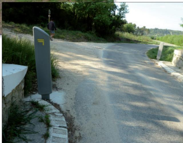
Balisage peinture à éviter sur la signalisation routière, celui-ci est toléré si il est sur adhésif et qu'il ne gêne pas la lisibilité de la signalisation routière par exemple en face arrière du mobilier, comme ici
